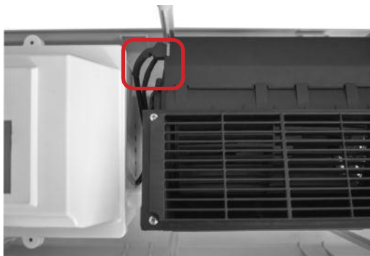
Fig. 7.4.2.6: De blowerstekker aansluiten
